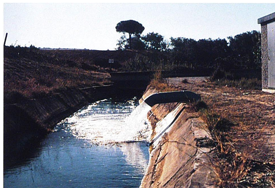
Detalle del Sondeo Arcos III bombeando un caudal de 100 l/s durante la última sequía (verano de 1995). Plan de Emergencia abastecimiento a la Bahía de Cádiz. (70)
